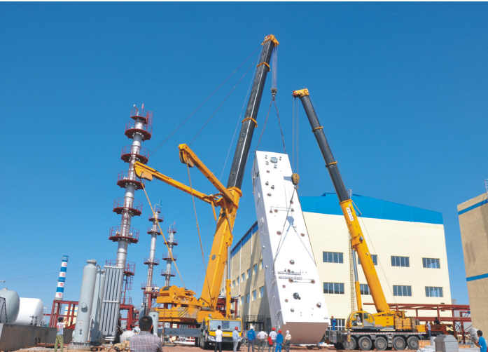
100 万方 LNG 液化冷箱整体吊装现场 Hoisting of 100x10 4 Nm³/h LNG liquefaction cold box in one piece
