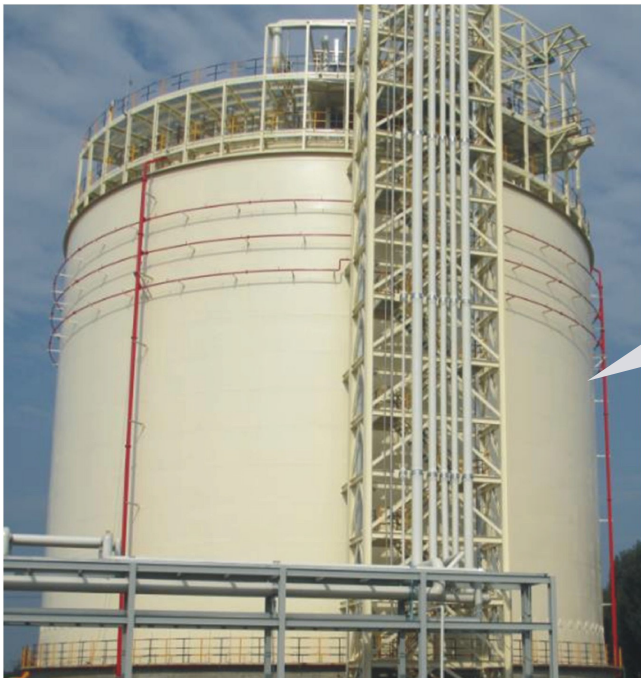
20000m 3 LNG 三壁金属全容罐 20000m 3 LNG Three Wall Full Containment Metal Tank
