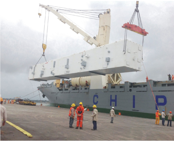
出口墨西哥 8000Nm³/h 空分冷箱在港口卸货 8000Nm³/h Air Separation Plant Cold Box Unloading, exported to Mexico
