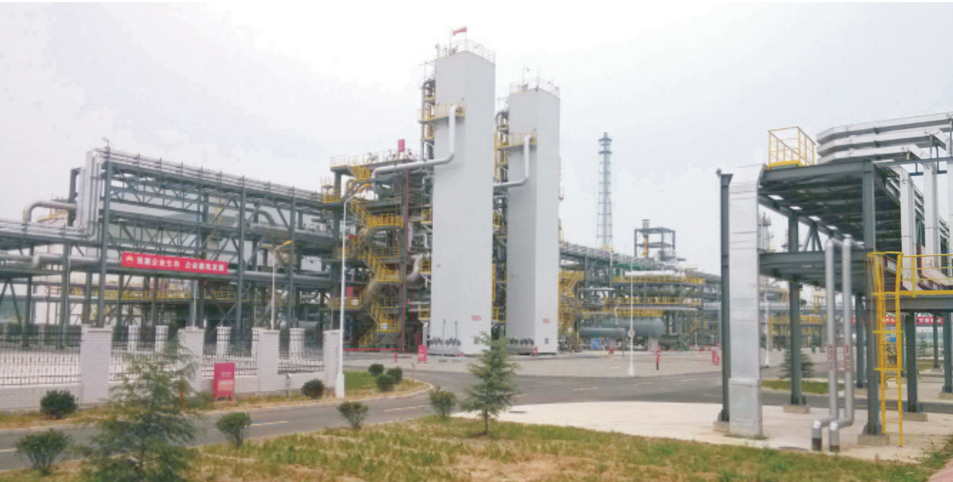
泰安 260 万 m 3 /dLNG 冷箱 2,600,000Nm 3 /d LNG Cold Box in Tai'an
